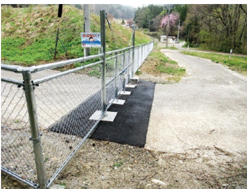
写真：大澤寺ため池フェンス
