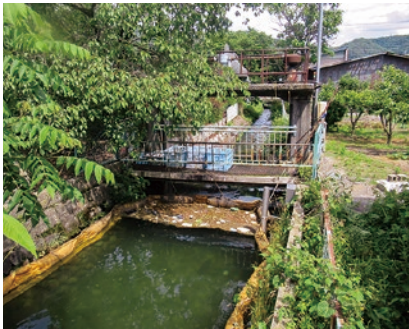
写真：町川残水（都市下水道）、毎日、農具川の4/1程度の水と大量の家庭ごみが流れている。
