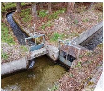
写真: 木崎三橋堂裏の中沢堰と上堰の分水。 写真左上が中沢堰。
