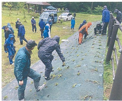
写真：R3の植栽作業の様子
