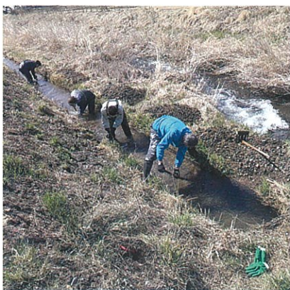
直営維持作業(横堰)
