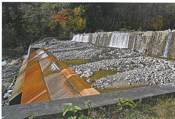
補強工事が行われる寄沢堰堤 (写真上部右側)
