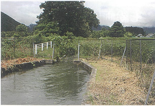
現在の大蔵宮堰の流況(行人塚沈砂地付近)
