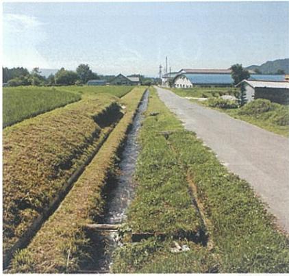
野口堰上流(中花見地区)
