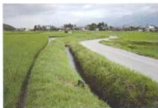
横堰（常光寺・館之内地区）
