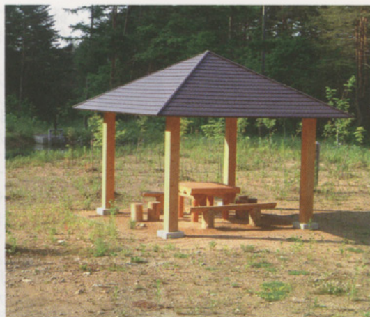
テーブルとベンチを据え付けました
