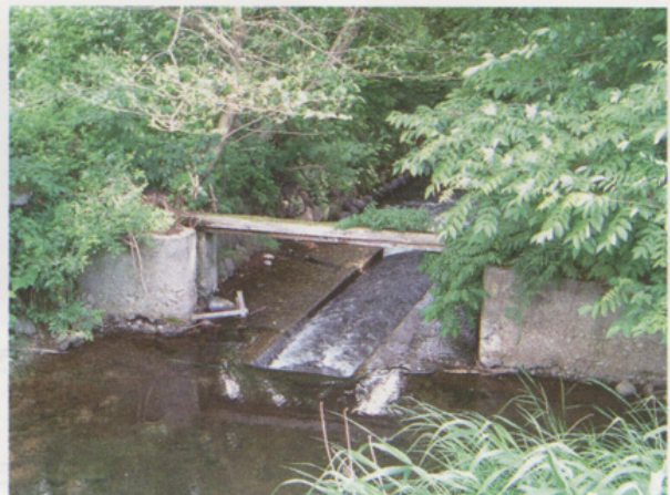
三間橋下流にある三口水門の跡
