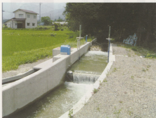
完成したチェックゲート
